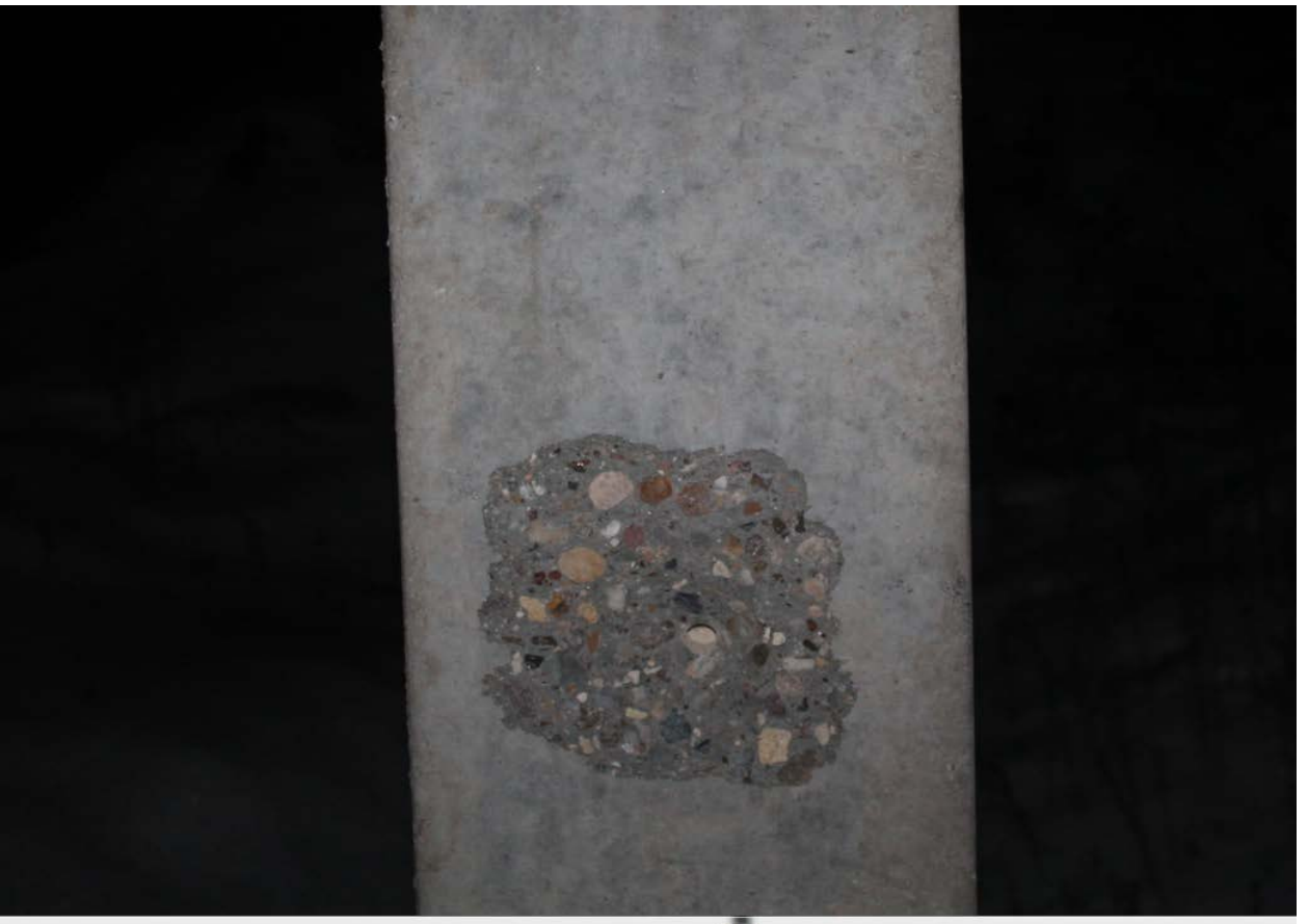
П. 7.2 Испытание свай методом отрыва со скалыванием
