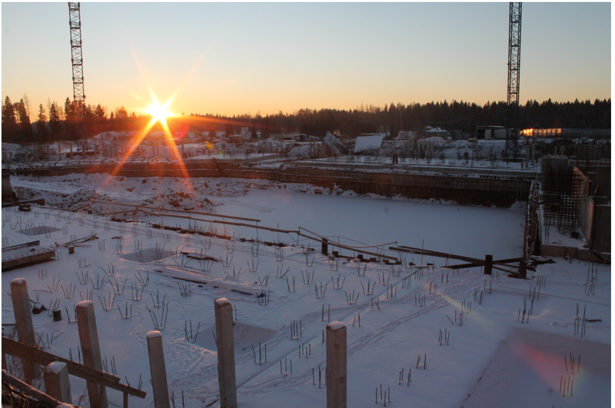
Рис. 2.2. Общий вид объекта.
