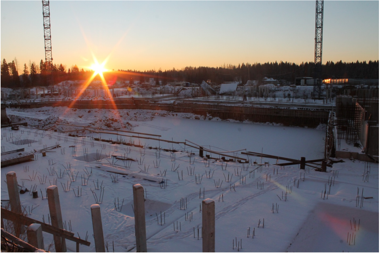
П. 5.1. Общий вид (1) котлована
