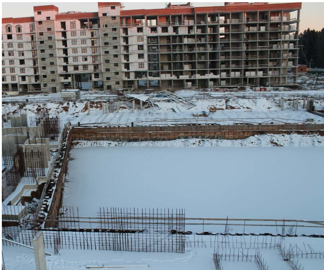
П. 5.8. Центральная часть котлована
