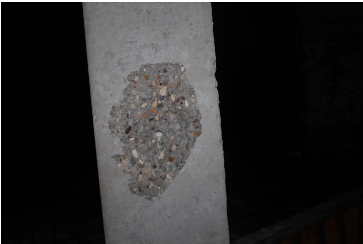
П. 7.3 Испытание свай методом отрыва со скалыванием
