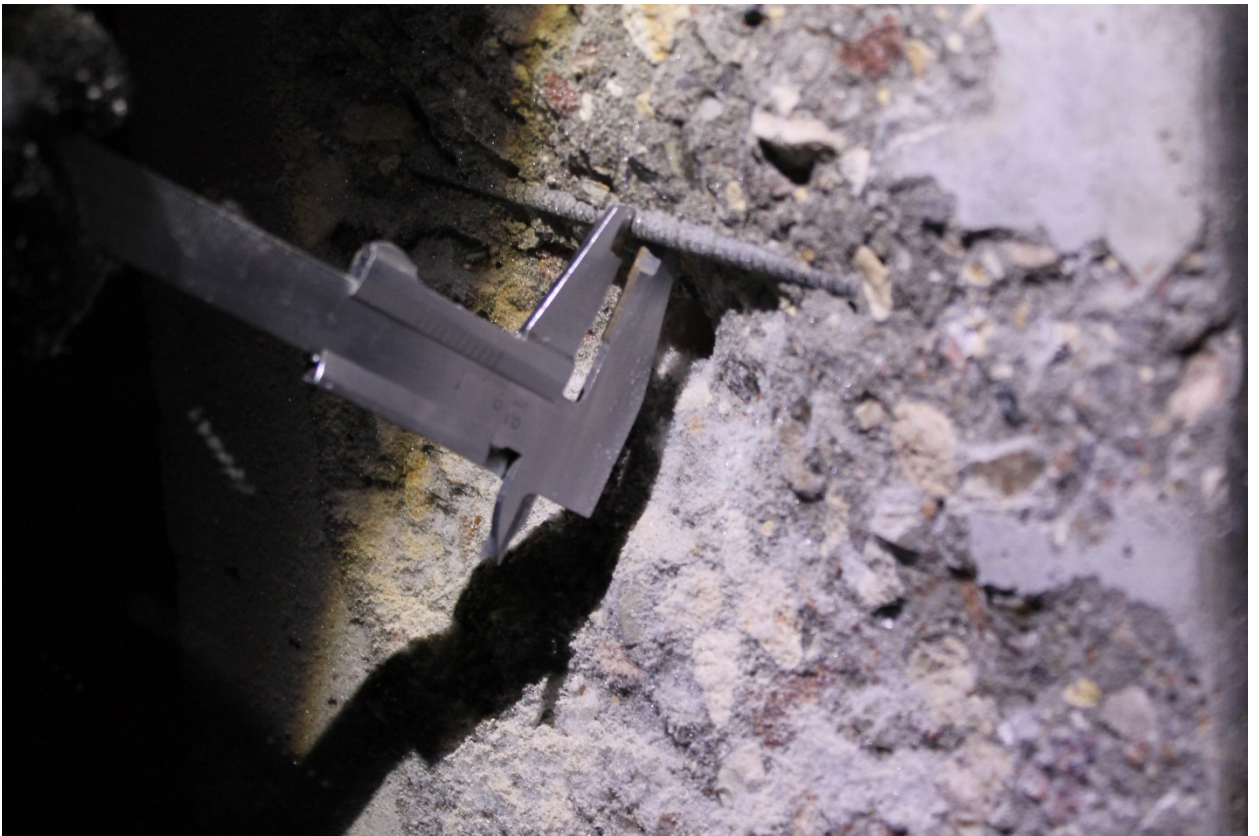
П. 7.7 Обмер диаметра арматуры
