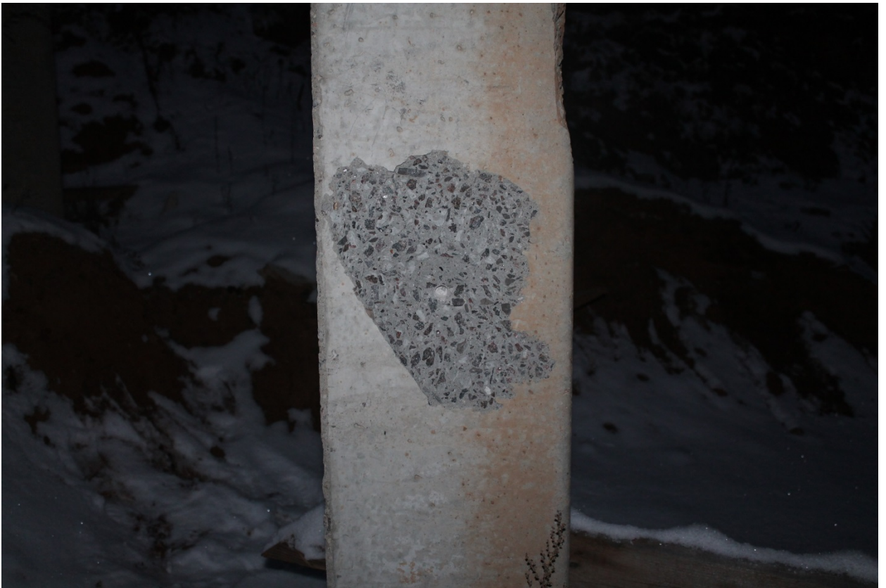
П. 7.1 Испытание свай методом отрыва со скалыванием
